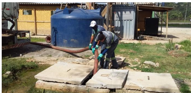
FOTO 3 – LIMPEZA DA FOSSA SÉPTICA
