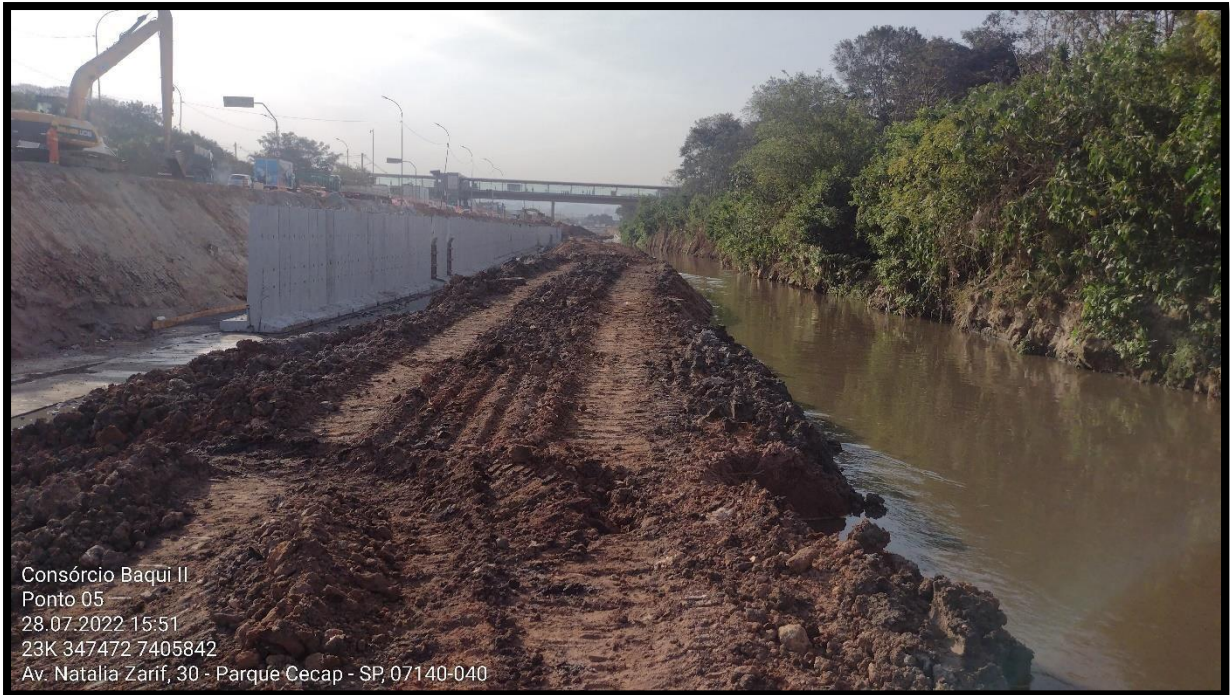
Figura 4 - Instalação de Ensecadeira
